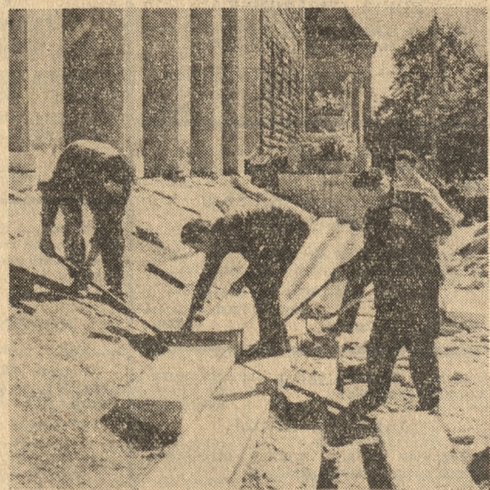
Wmurowywanie nowych stopni.
