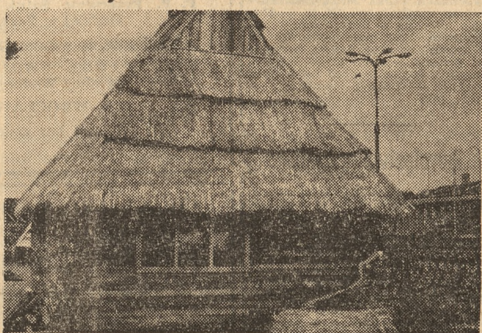
Budowana nad Wisłą obok Stadionu X-lecia na Święto Trybuny Ludu stylizowana wioska jest już prawie gotowa. Na zdjęciu: stylowa karczma.
