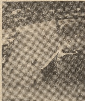
Na zdjęciu — betonowa skarpa (5,8 m wysokości, kat 51 stopni), po której H. Koral stoczył się do Kanału Mosińskiego. Fot. — „Głos”
