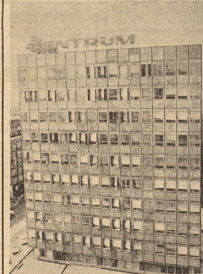
W upalne dni, gładkie powierzchnie ścian wieżowców Cen- trum, rozchylają się setkami okien. Mimo zasłan na szybach i wentylacji wewnątrz, skwar tropikalny. (tt)
