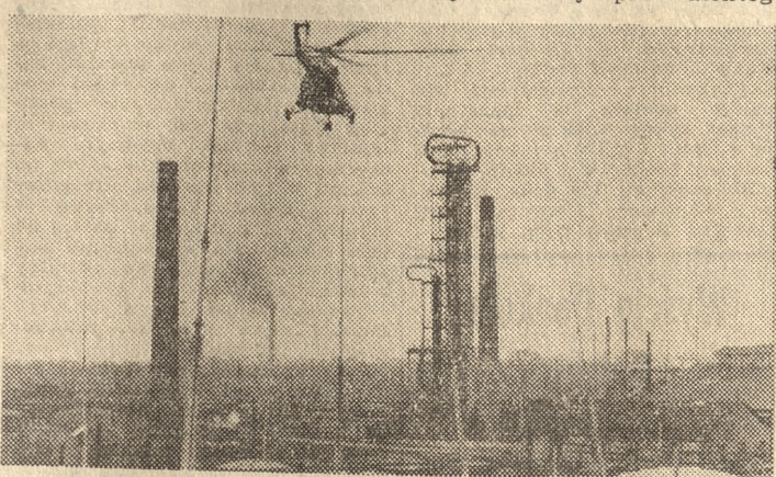
Śmigłowiec nad rafinerią ropnaftowej Czechowice-Dziedzice. Dzięki użyciu śmigłowca do montażu 150 iglic ogromowych, zakład zaoszczędził 20 milionów zł.
