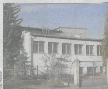
W tym budynku powstanie dom dziennego pobytu seniora
