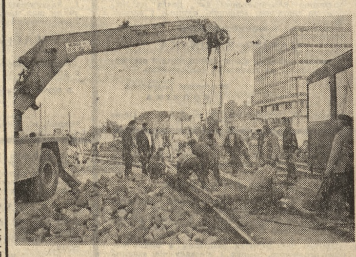
Przy Moście Dworcowym i na ul. Roosevelta trwa praca. Brygady Miejskiego Przedsiębiorstwa Komunikacji przeprowadzają tam wymiane rozjazdów tramwajowych. Przed zbliżającymi się Targami jest to dla usprawnienia komunikacji bardzo ważne. Fot. — K. Przychodzki
