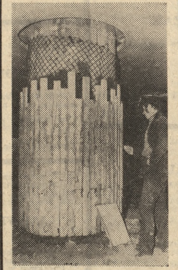
Brygadysta Bogdan Madej sprawdził wytrzymałość specjalnie przygotowanego uzbrojenia filaru. Do piero potem będzie można przy mocować do niego trawertynowe płyty. Fot. (2) — K. Przychodźki
