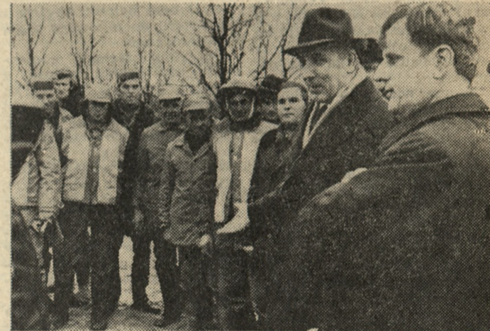
Spotkanie z pracownikami na budowie trasy E-8. Drugi od prawej — Edward Gierek, pierwszy od prawej — Jerzy Zasada.
