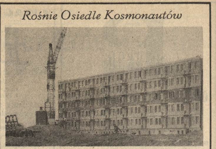
Budowa Osiedla Kosmonau- tów na Winogradach trwa w całej pełni. Dwa domy znaj- dują się pod dachem, [na zdjęciu], przy kilku następ- nych prace są daleko zaawansowane. Wkrótce w pierwszym wybudowanym do- mu zamieszkają lokatorzy. Fot. — K. Przychodzki
