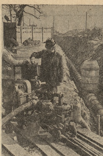
Pracownicy WPRW-K przy pomie odwadniającej odcinek kolepu, w którym układany jest kolepu.
