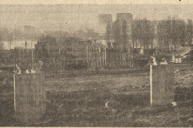
Pierwsze mrozy nie osłabiły tempa prac przy budowie Trasy Łazienkowskiej w Warszawie. Na szeregu odcinków nowego szlaku komunikacyjnego wykonawstwo wyprowadza harmonogramy. Dotyczy to także rejonu budowy nowego mostu. Na zdjęciu: filary mostu na przyczółku praskim. W głębi widoczne filary wznoszone w nurcie Wisły.
