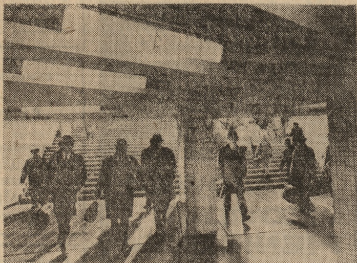
Łączną długość podziemnych przejść dla pieszych zbudowanych w Moskwie, można już liczyć na kilometry. Pozwalają one na znaczne usprawnienie ruchu pojazdów w stolicy Kraju Rad. Na zdjęciu: przejście pod placem Świerdłowa.
