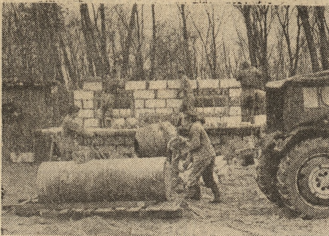
W Szamotułach trwają wyłożone prace przy budowie nowego ośrodka sportowo-rekreacyjnego — obiektu, na który wszyscy mieszkańcy miasta i okolicy czekają z niecierpliwością. Fot. — M. Różański
