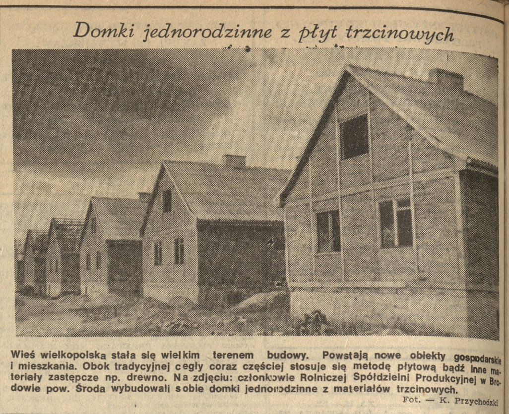
Wielkopolska stała się wielkim terenem budowy. Powstają nowe obiekty gospodarskie i mieszkania. Obok tradycyjnej cegły coraz częściej stosuje się metodę płytową bądź inne ma- teriały zastępcze np. drewno. Na zdjęciu: członkowie Rolniczej Spółdzielni Produkcyjnej w Bro- dowie pow. Środa wybudowali sobie domki jednorodzinne z materiałów trzcinowych. Fot. — K. Przychoździ
