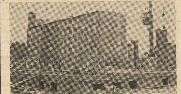
Budowa osiedla mieszkaniowego w Buku.
