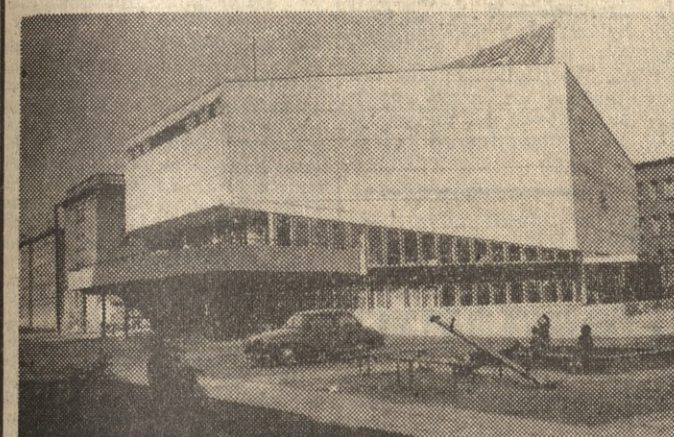
W Koninie, na pl. Górnika, dobiega końca budowa sali zbiornej dla załóg kopalni węgla brunatnego. Na zdjęciu — piękna architektura budynku, którego inwestorem jest Kopalnia Węgla Brunatnego Konin. Fot. — K. Przychodzki
