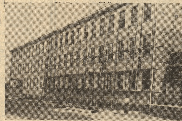
Prace elewacyjne frontu budynku Szkoły Podstawowej nr 4 w Jarocinie zakończono. Zdejmowane obecnie rusztowanie stanie od strony dziedzińca.
