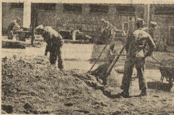
Prace remontowe Szkoły Podstawowej nr 4 w Krotoszynie postępują zgodnie z harmonogramem, dzięki sumiennej pracy żołnierzy. Na zdjęciu: przygotowanie materiału do prac murarskich.
