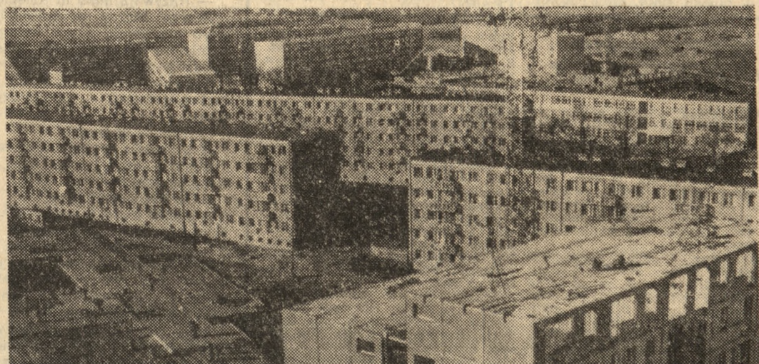
Winogradi — jeden z większych w Poznaniu plac budowy bloków mieszkalnych. Fot. — K. Przychodzki
