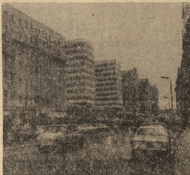
Ozdobą jednej z głównych arterii Poznania jest 5 wieżowców, z których trzy czynne są już od lat kilku. W dwóch budynkach — należących do „Miasoprojektu” i „Meramontu” trwają prace wykończeniowe. Do końca tego roku mają być gotowe części wysokie tych budynków. Prace w niższych partiach, przeznaczonych na usługi potrąją do 1973 r. Na zdjęciu: Na pierwszym planie zmierzający hotel „Lech” za nim — wieżowce przy ul. Czerwonej Armii. Fot. — K. Przychodźki
