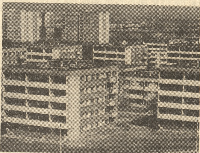
Fragmenty osiedla Sady I na Żoliborzu w Warszawie.
