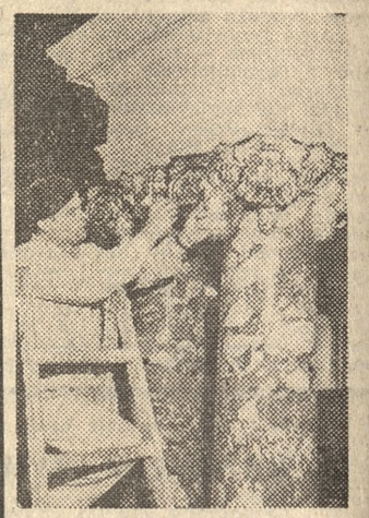
Na zdjęciu: pozłotnik p. Zygmunt Konieczny nakłada płatek „ziółta” na głowicę kołomy na balkonie auli. (z) Fot. (2) — K. Przychodzki
