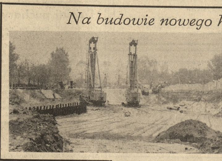
Na budowie nowego hotelu
