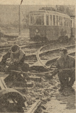
Na zdjęciu: prace przy montowaniu rozjazdu szyn tramwajowych u zbiegu ul. Świerczewskiego i Roosevelta.
