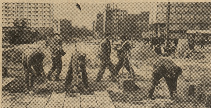
Od strony ul. Zwierzynieckiej trwa na wiadukcie układanie płytek chodnikowych.
