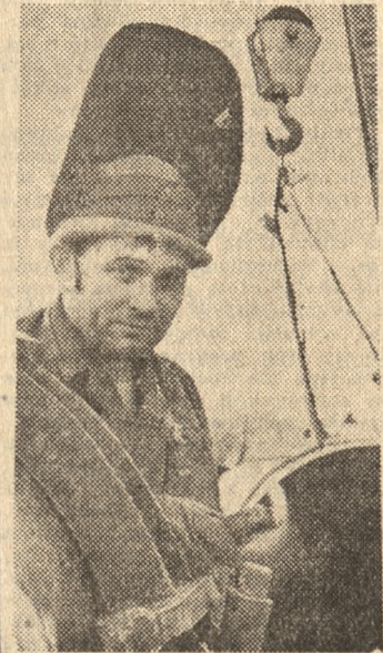
Józef Giel z Poznania — brygadzieta jednej z najlepszych „czołówek” pracujących przy budowie ropociągu.
