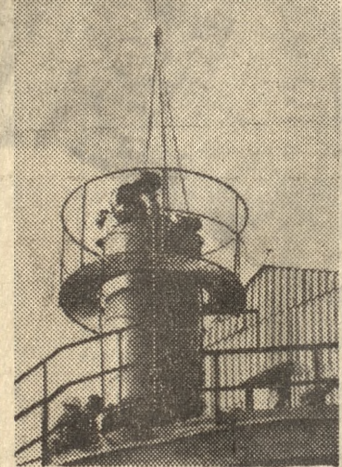
Na zdjęciu moment montażu filtrów na szczycie 35-metrowego silosu.
