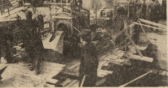
Specjalny agregat doprowadza beton na stanowisko pracy. Tutaj zalewa się konstrukcję przygotowaną z misternie ułożonej stalowej siatki.
