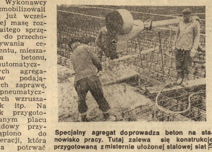
Specjalny agregat doprowadza beton na stanowisko pracy. Tutaj zalewa się konstrukcję przygotowaną z misternie ułożonej stalowej siatki.
