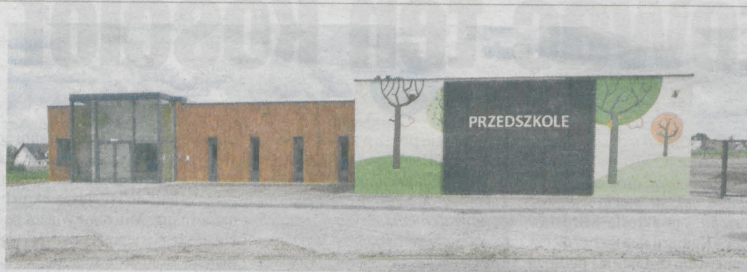
Przednia elewacja nowego budynku przedszkola w Jaraczewie
