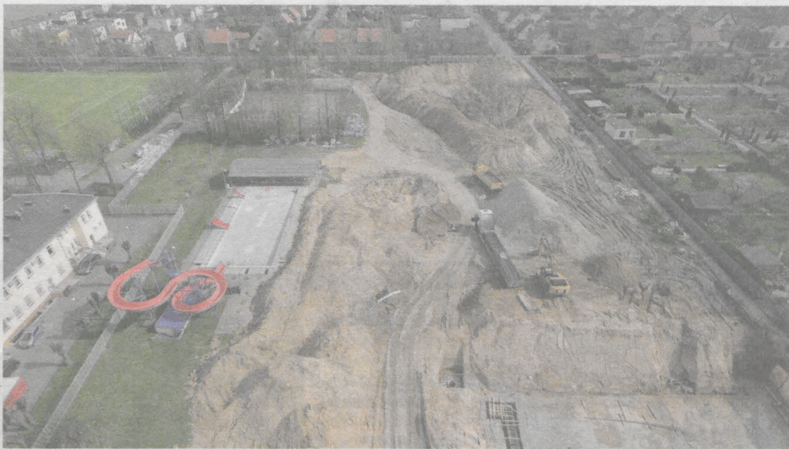
Tak obecnie wygląda teren budowy nowych obiektów spółki Jarocin Sport
