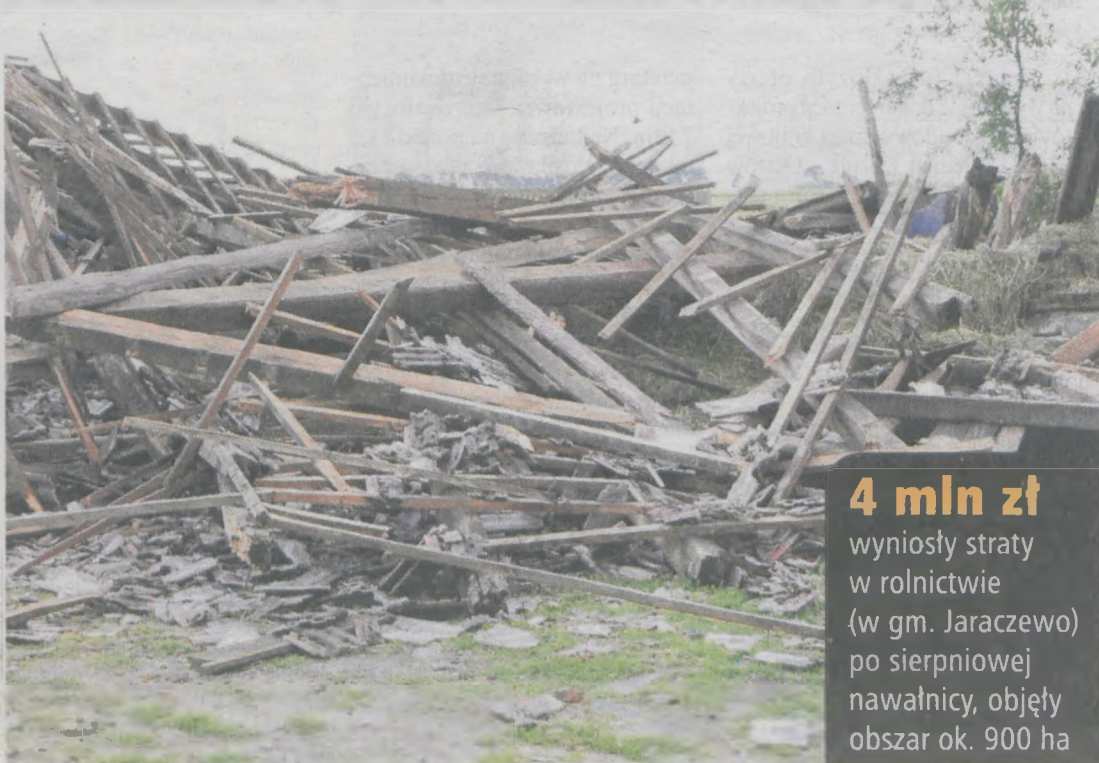
Sierpniowa nawałnica zniszczyła wiele budynków na terenie gminy Jaraczewo
