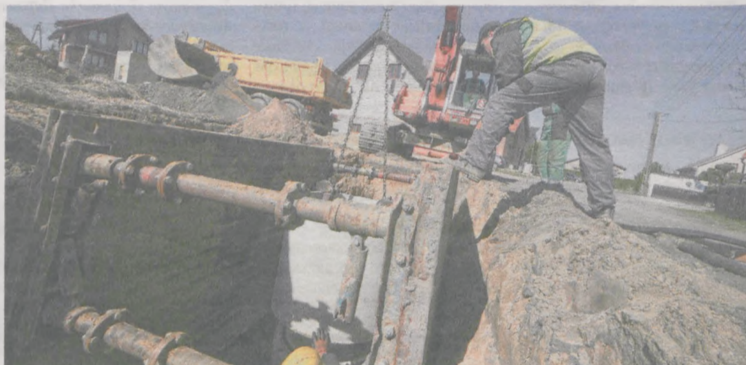
Firma Drobud wybuduje sieć wodociągowo-kanalizacyjną do ubojni drobiu w Golinie
