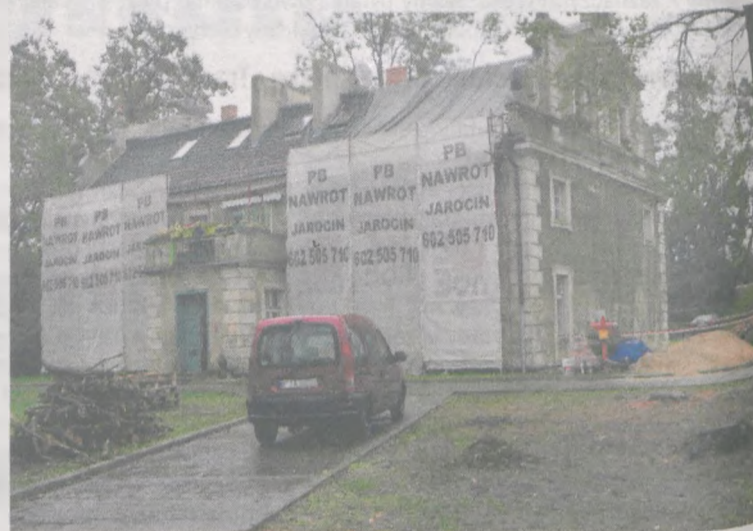
Remont dachu na pałacu w Porębie powinien potrwać do końca listopada
