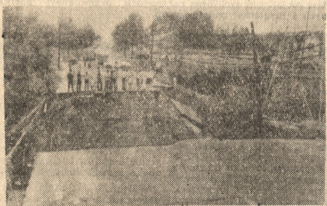
Wskutek ulewnych deszczów we wschodnich rejonach stanu Maryland (USA) zapadła się autostrada koło Baltimore, na odcinku kilkudziesięciu metrów.
