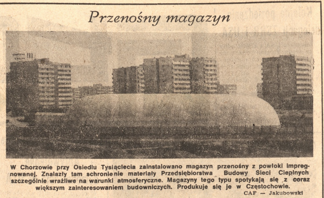
W Chorzowie przy Osiedlu Tysiąclecia zainstalowano magazyn przenośny z powłoki impregnowanej. Znalazły tam schronienie materiały Przedsiębiorstwa Budowy Sieci Ciepłych szczególnie wrażliwe na warunki atmosferyczne. Magazyny tego typu spotykają się z coraz większym zainteresowaniem budowniczych. Produkuje się je w Częstochowie. CAF — Jakubowski
