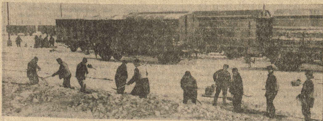
Drużyny pociągu zmechanizowanego dbają o to, by tory były stale czyste.
