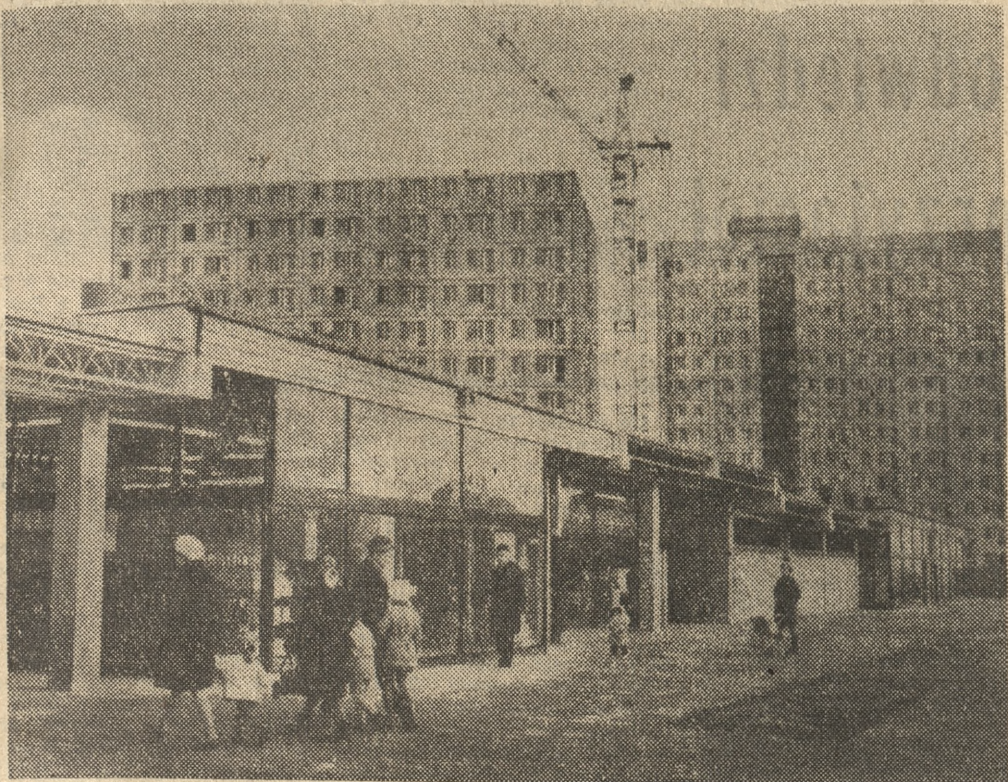
Winograpy — drugi po Ratajach największy w Poznaniu plac budowy, rozrastają się w błyskawicznym tempie. Na zdjęciu: trzynastopiętrowe bloki mieszkalne i pawilony handlowe wybudowane w 1971 roku.
