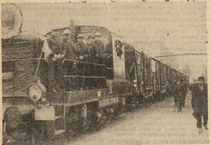
Na zdjęciu: wagony, wyremontowane przez ZNTK w Ostrowie przekazane do użytku w dniu wczorajszym. Fot. — K. Przychodźki
