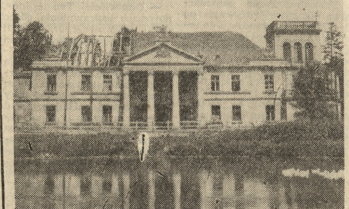
Dziś nad pałacem w Gębicach wznosi się już kompletny dach, zaś wszystkie otwory są zamurowane cegłą dziurawką zapewniającą wentylację obiektu.
