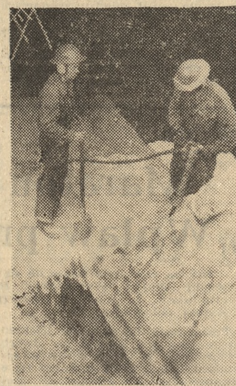
Część starych murów Kaponierzy trzeba usunąć przy pomocy młotów pneumatycznych. Na zdjęciu — rozkuwanie ceglanej ściany.
