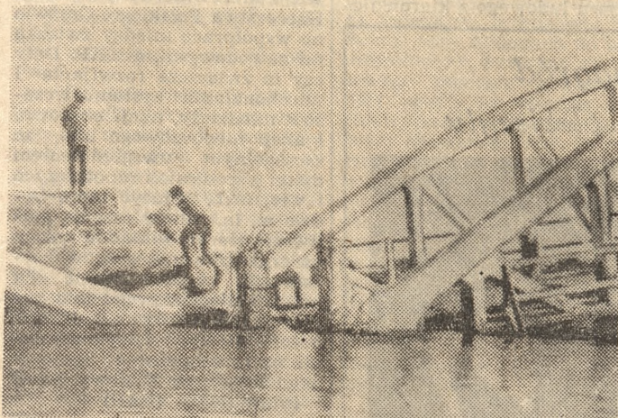
Sily patriotyczne Kambodży wysadziły w powietrze most w pobliżu miejscowości Pursat. Przez most ten przebiega ważna strategiczna droga z prowincji Battambang do stolicy Phnom Penh.
