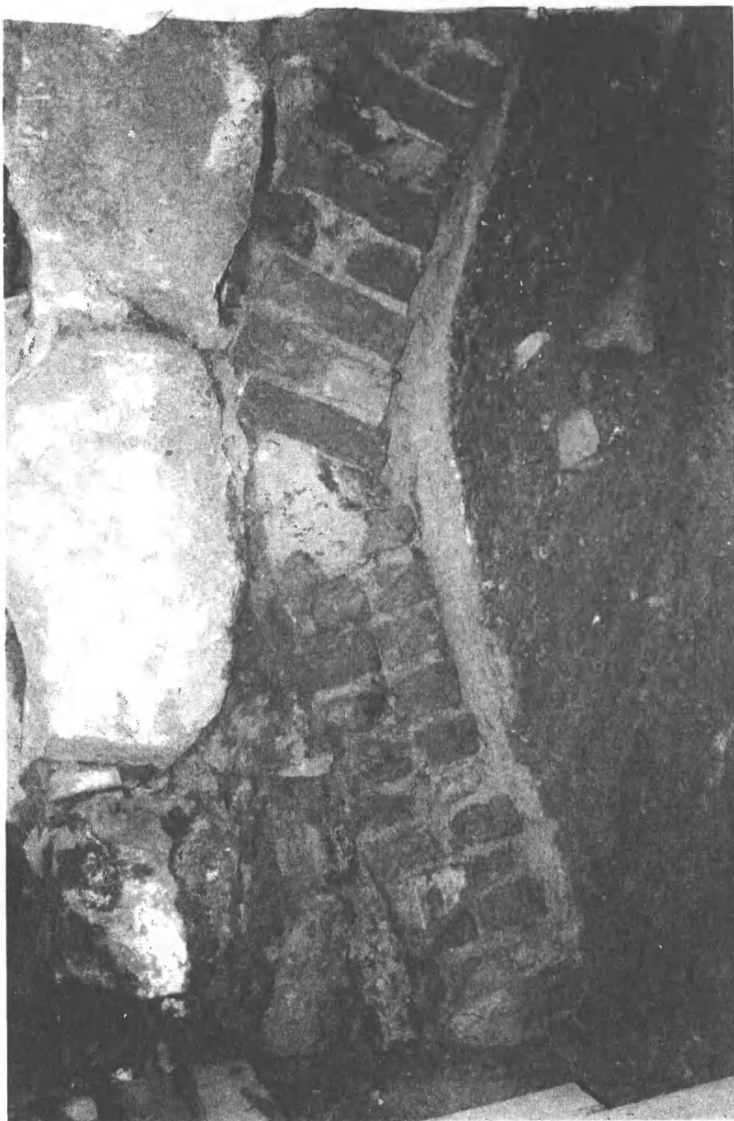
Ryc. 6. Ostrów Tumski. Wykop 5. Fundament budynku gotyckiego
