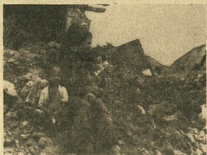
W wyniku tragicznej katastrofy trzęsienia ziemi, która 30 lipca nawiedziła północno-wschodnie rejony Iranu, zginęło 175 osób, a 450 zostało rannych. Wiele miast i wiosek uległo zniszczeniu. Na zdjęciu: matka z dziećmi na ruinach swojego domu. CAF — UPI — telefoto
