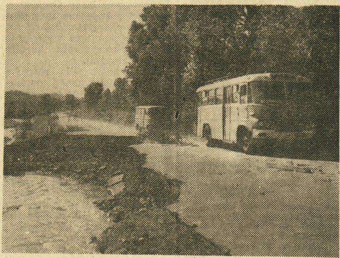
W województwie krakowskim powódź wyrządziła wielkie szkody. Na zdjęciu: zniszczona przez rzekę szosa Nowy Sącz — Krynica. Fot. — CAF
