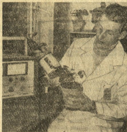
Przyrząd, który trzyma w ręku mgr Edward Czaplicki wykrywa skażenie radioaktywne roślin, opryskanych pestycydami oznakowanymi izotopem kobaltu 60.
