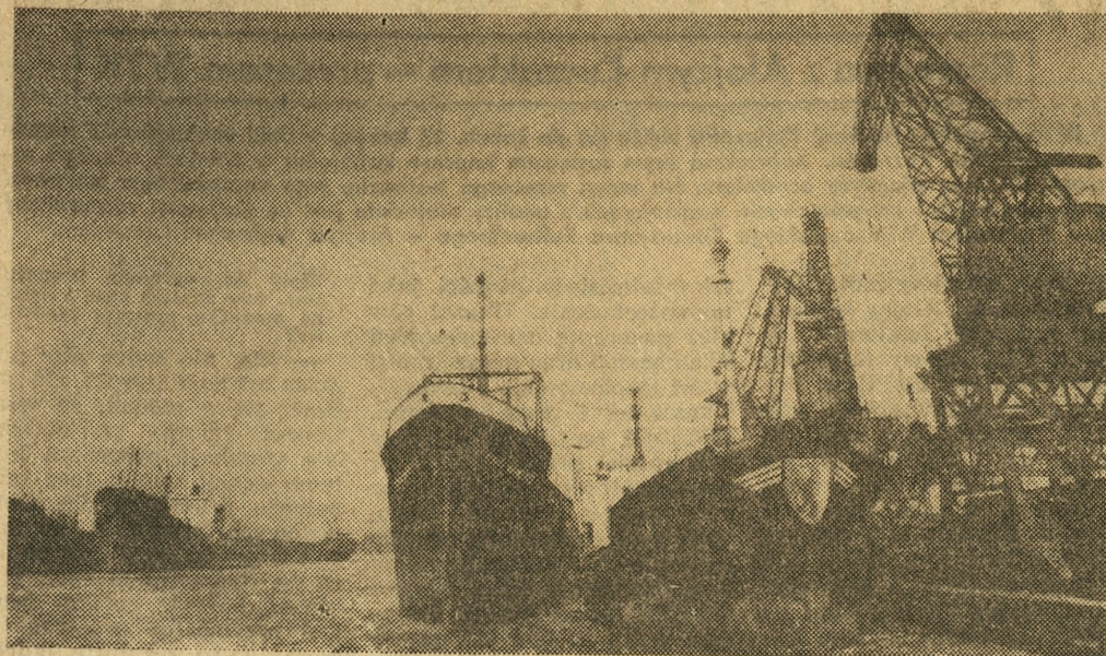
W 25-lecie port szczeciński odwiedziło 100 tys. statków różnych bander całego świata. Ten wielki ośrodek przeładunkowy, całkowicie odbudowany ze zniszczeń wojennych, oddawał całej gospodarce krajowej nieocenione usługi. Przeładowano tu ogółem 180.506,4 tys. ton towarów. Na zdjęciu: basen węglowy portu szczecińskiego.
