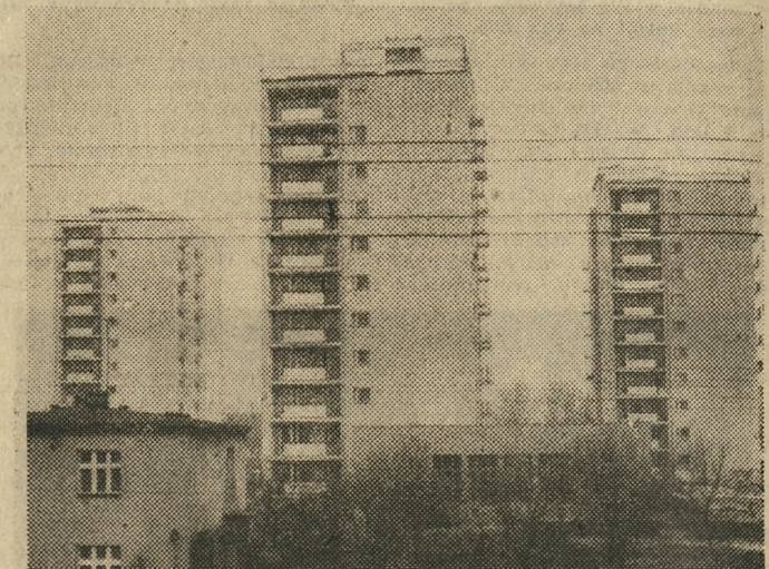
Na zdjęciu: trzy budynki przy ul. Palacza. Fot. — K. Przychodaki
