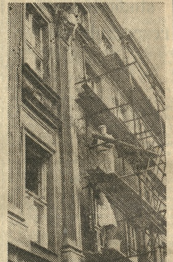
Na zdjęciu — remont elewacji jednej z kamieniczek między ulicami Wroniecką i Wielką. (c)
