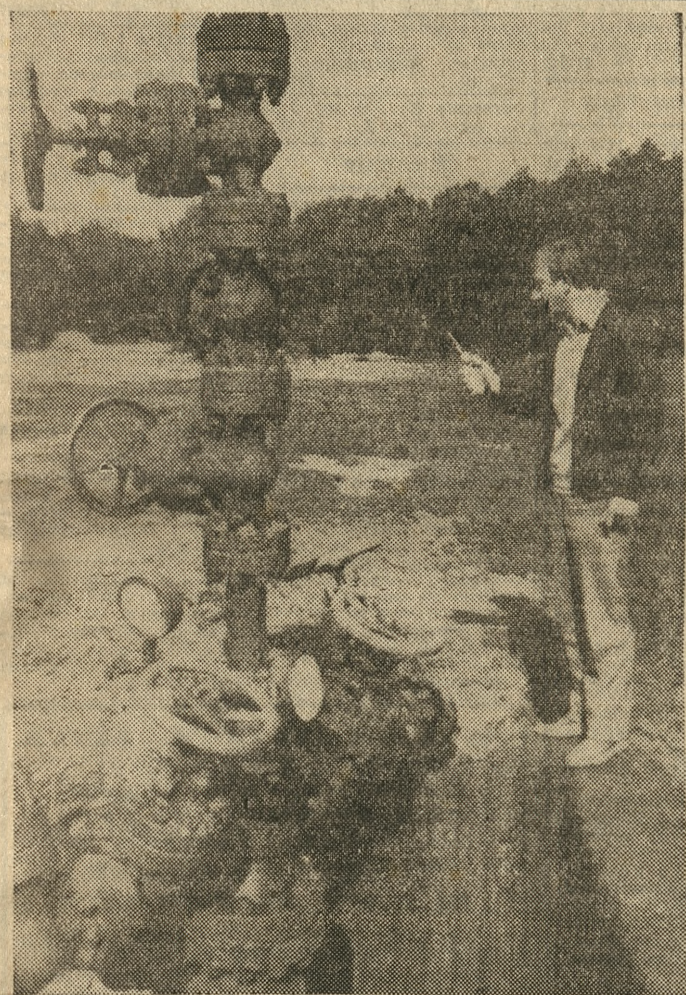
W miejscu wczorajszej batalii nie ma już brygad roboczych. Tylko ekipa laboratorium Ochrony Powietrza z Prezydium WRN w Poznaniu, badała m. in. stężenie metanu na terenie awarii. Na zdjęciu — głowica z zaworami.
