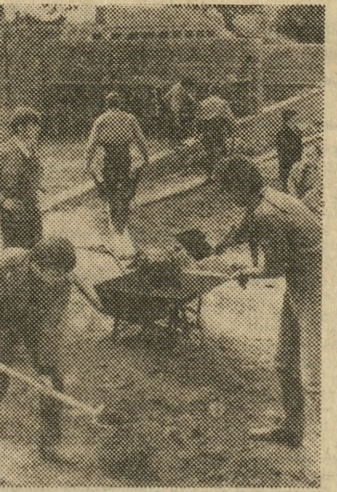
Na zdjęciu — grupa harcerzy przy budowie Ośrodka Harcerskiego. Fot. (2) — K. Przychodźki
