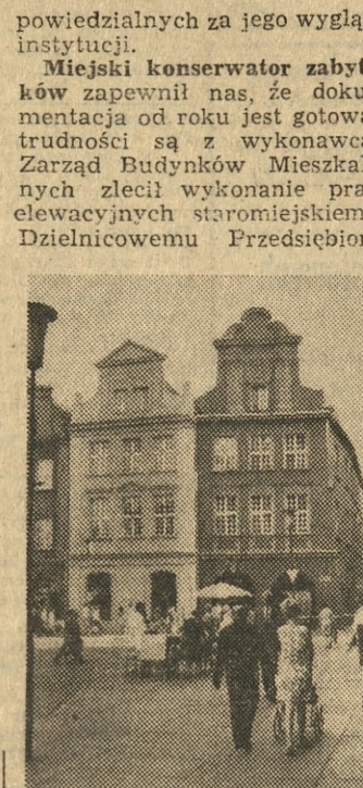
Wiele odcinających Stary Rynek kamieniczek wymaga już remontu. Prace te prowadzi się kolejno w poszczególnych domach. Niektóre kamieniczki — jak te na zdjęciu, przy narożniku ul. Szkolnej — już odnowiono. Na inne, których elewacje zdradzają zniszczenie, nadejdzie także kolej. (c)
